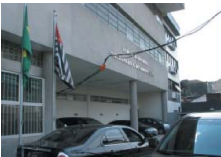
“Tigre” na instalação elétrica do fórum
