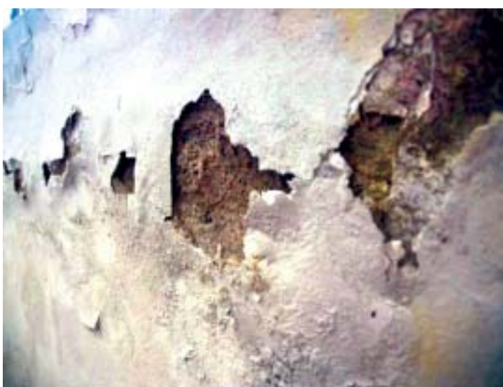
Parede embolorada pela umidade
