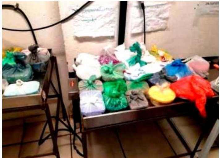
Marmiteiras e fiação elétrica: “grave risco”.
